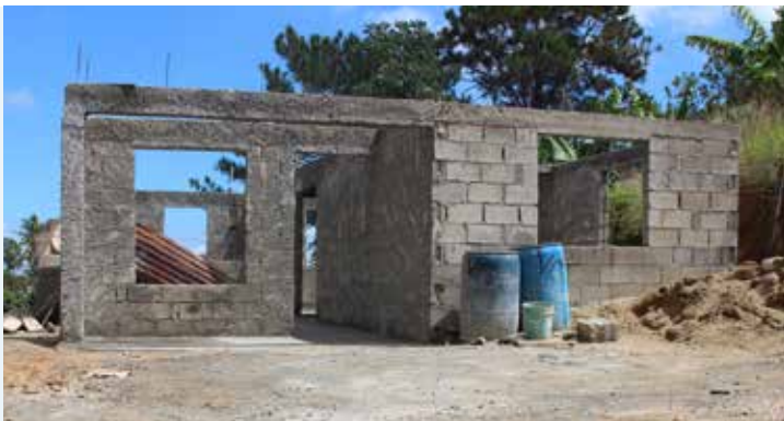
Apoyo para reconstrucción de vivienda
